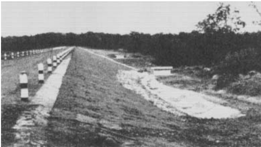
รูปที่ 19 แสดงการปลูกหญ้าลาดเขื่อนดิน
