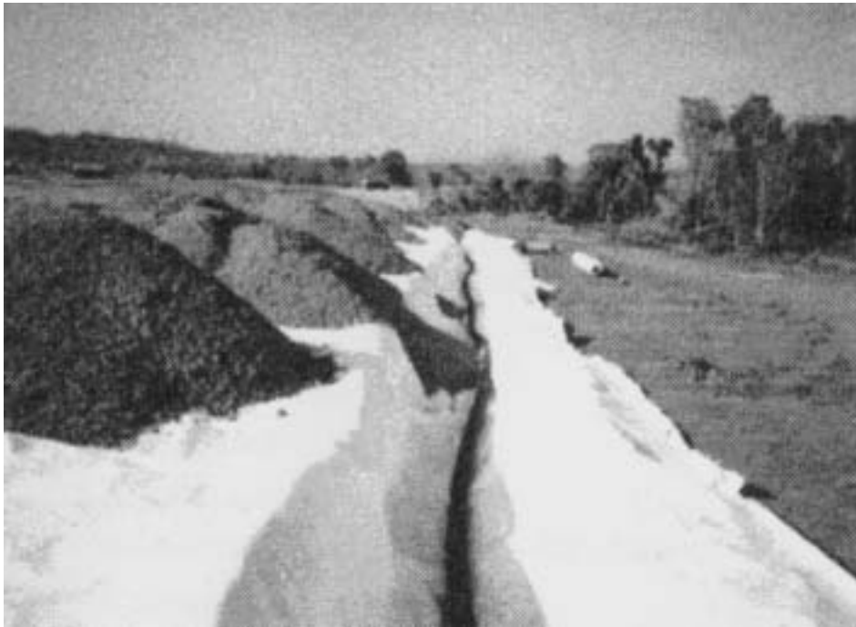
รูปที่ 20 แสดงการปูวัสดุกรอง Toe Drain ของเขื่อนดิน
