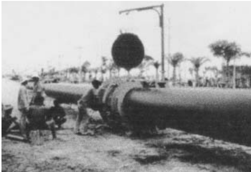
รูปที่ 15 แสดงการเชื่อมต่อท่อ HDPE โดยวิธีต่อชน
