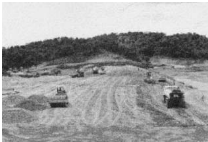
รูปที่ 5 แสดงการถมบดอัดดินแกนเขื่อน
