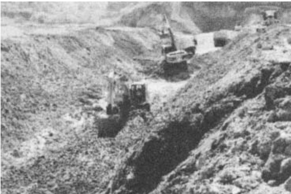
รูปที่ 3 แสดงการขุดดินเหลว หรือดินชุดร่องแกน
