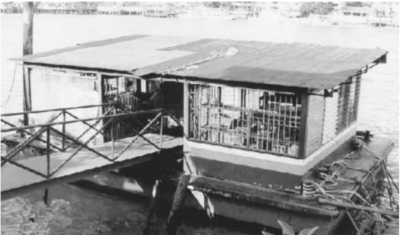
รูปที่ 9 สถานีบริการน้ำมันเชื้อเพลิงประเภท จ. ลักษณะที่ 2 (สถานีบริการทางน้ำขนาดใหญ่)
